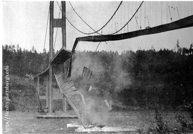
Fig. 4.2 – Effondrement du pont de Tacoma Narrows à la suite d'un effet de couplage aéroélastique entre la force exercée par le vent et le déplacement du tablier.
