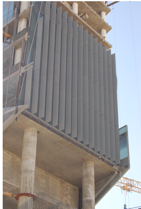
Fig. 2 : Projet KAFD4.01, Riyadh, Arabie Saoudite. Objets : Ailerons externes et wingwall. Façades : Scheldebouw (groupe Permasteelisa). Architecte Perkins+Will Source image : Guido Caubo
