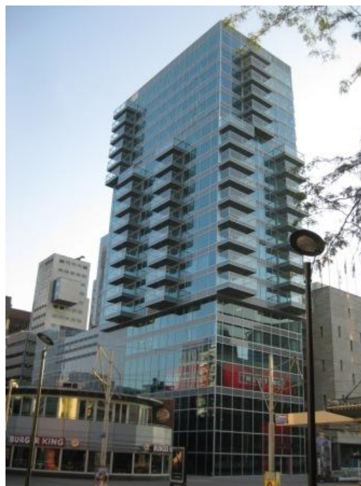
Fig. 4 : Projet B-toren, Rotterdam, Pays-Bas. Objets : balcons et habillages Façades : Scheldebouw (groupe Permasteelisa) Architecte Wiel Arets Source image : www.boag.com
